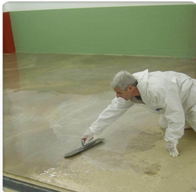
24 heures après, il sera possible d'appliquer un système filmogène, semi-épais ou une résine coulée (autolisante)
